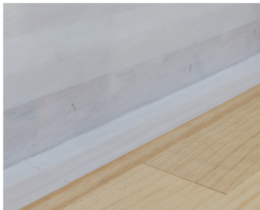
床下の気密処理例
