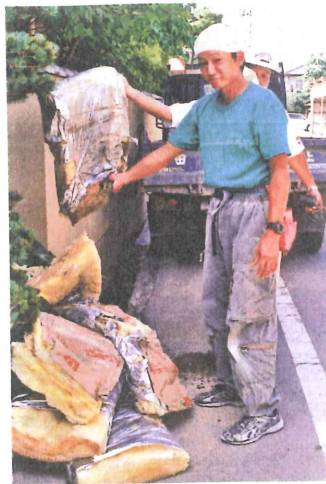
家屋から持ち出された断熱材しぼると泥水が落ちてくる
