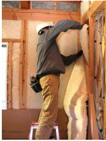
② 筋交いの裏にウールブレスを入れ込んで充填します。
