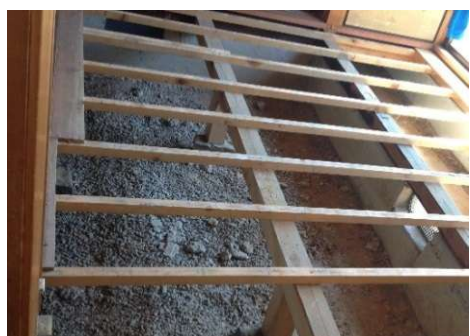
① 土台・大引の上面に床根太を施工します。
