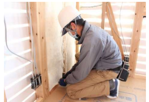
⑨ 折り込んだ部分をタッカーで固定して完了です。
