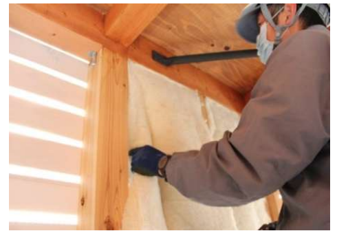
⑥ しわと隙間ができないよう注意しながら充填していきます。
