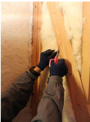
④ 筋交いに沿って切り込みを入れます。(50mm程度)
