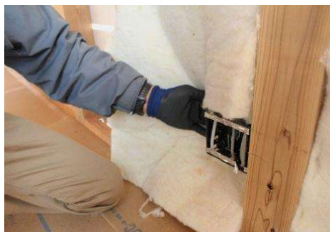
② 切り込んだ部分をボックスの後ろに回します。ボックスの後ろに隙間ができないよう、注意して下さい。
