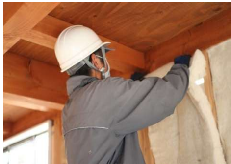
④ 折り曲げた状態のまま上部に押し当てて充填します。
