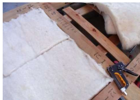
③ ウールプレスを敷き込んで施工完了です。
