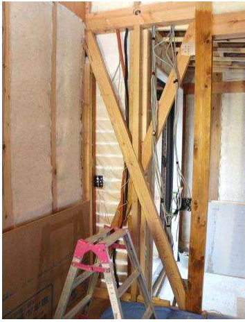
① 壁の高さを採寸し、ウールブレスを寸法に合わせてカットします。
