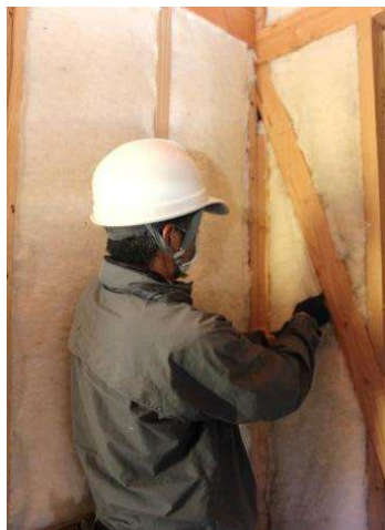
⑤ 切り込んだ部分をタッカーで固定します。 あとは「壁への施工・基本の壁」と同様に施工します。
