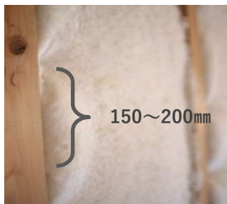
2.タッカー(ステープラー)の間隔は150~200mmです。
