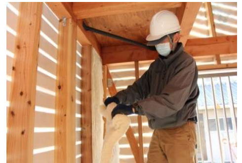
③ ウールブレスの上端を折り曲げます。
