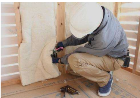
① コンセントボックスの高さに沿って切り込みを入れます。
