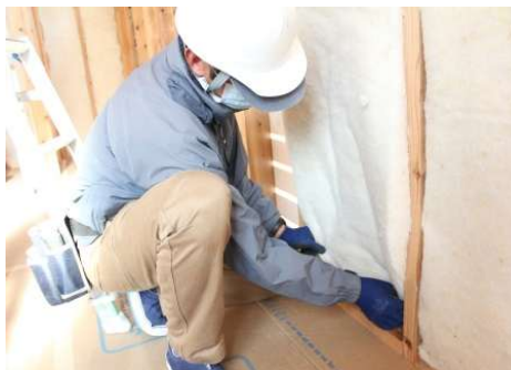
⑧ 下部折しろ部分を折り込むように納めます。
