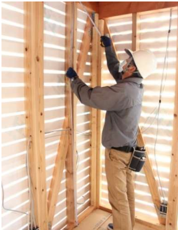
① 充填する箇所を採寸します。
